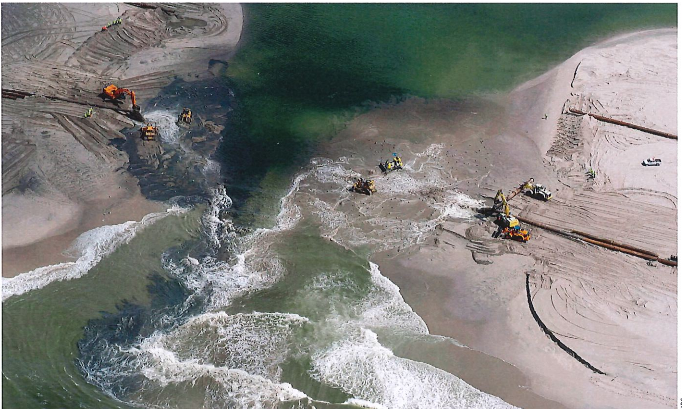
Défense maritime en construction.
