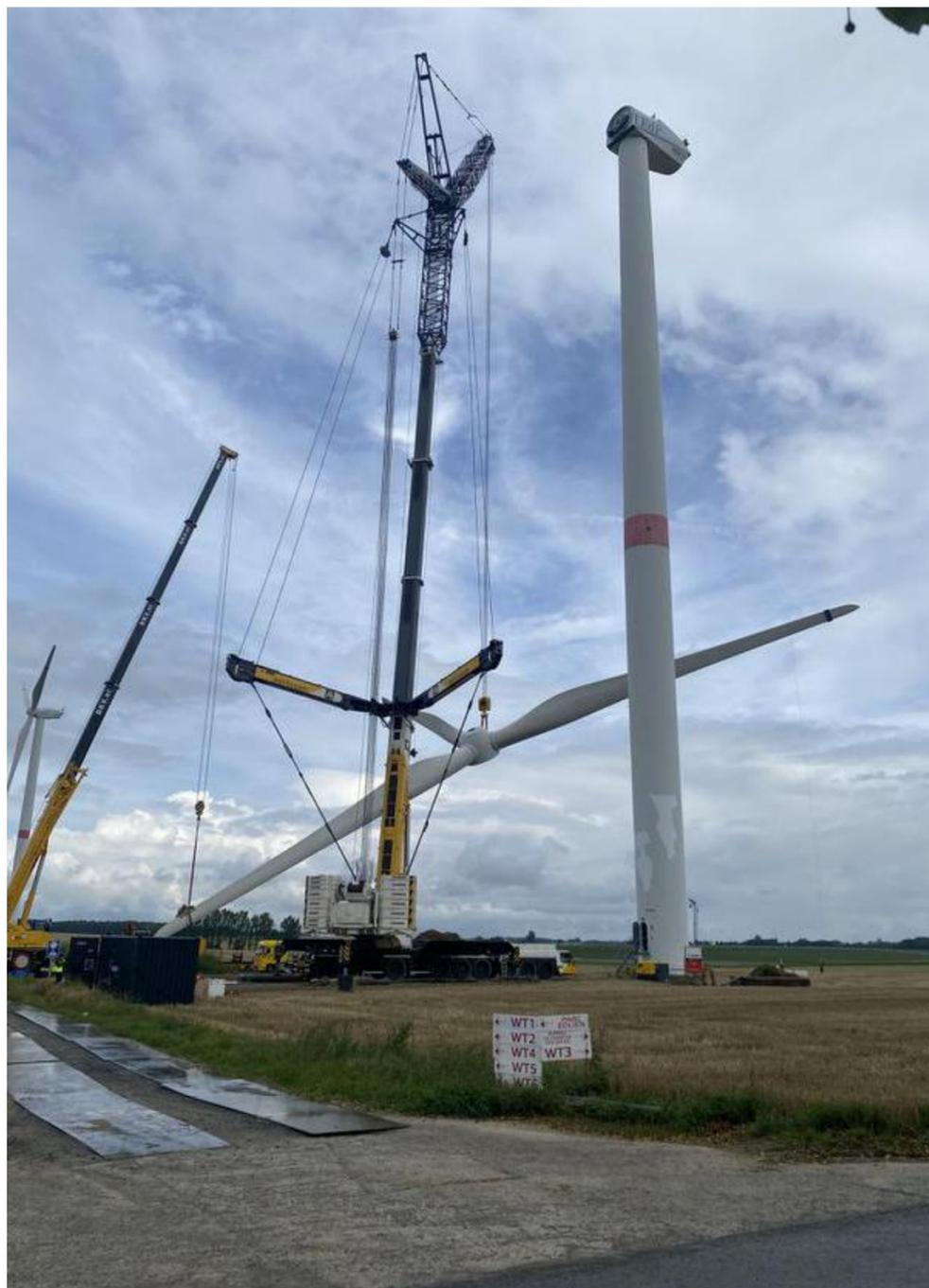
Le parc éolien de Perwez en cours de « repowering ». Engie et Eneco y démontent huit éoliennes mises en service en 2005 et 2006, pour en replanter sept autres. © Z\_INDEFINI.
