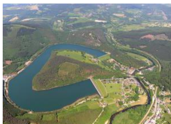
Les travaux sur le bassin inférieur (ci-contre) et l'un des deux bassins supérieurs de la station de pompage-turbinage de Coo ont permis d'augmenter le volume de stockage d'eau de 450.000 m 3 . © BARSE RUDY.
