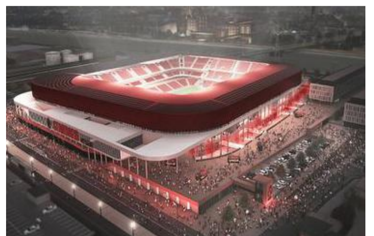
Aujourd'hui, le projet de rénovation est à l'arrêt. © DR.
