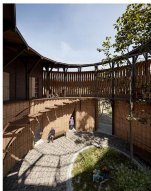
Projet de Toulon, un habitat communautaire en terre, au Fujiang, en Chine, où l'impression 3D permet de concevoir la structure même de la construction comme un filtre climatique. © IAAC
