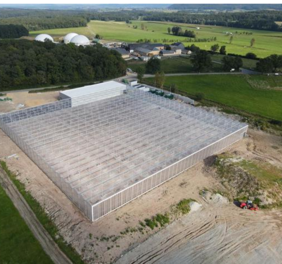
Les serres sont fonctionnelles depuis un petit mois et produisent des tomates, chauffées à 100 % au biogaz. © DR.
