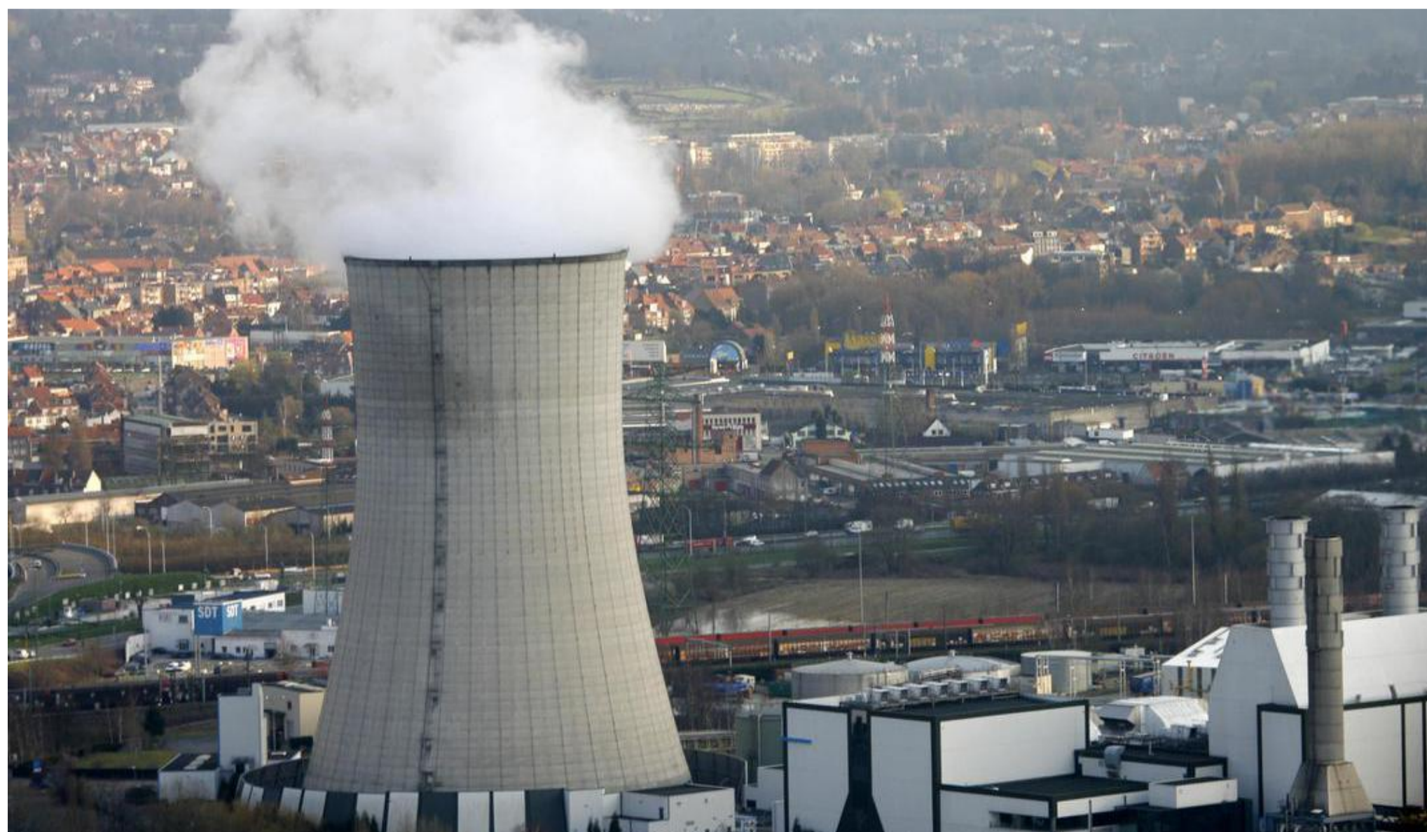
La centrale au gaz de Drogenbos.
